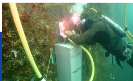
水中溶接作業の様子
