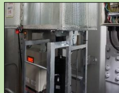
風車内の昇降装置
