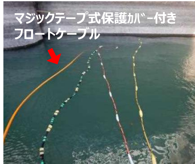
新方式 (フロートケーブル方式)
